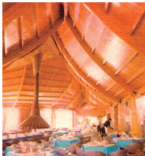
Restaurant construido con madera laminada encolada en la ciudad de Córdoba.
